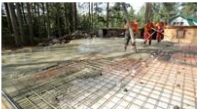
Заливка бетона с использованием бетононасоса
