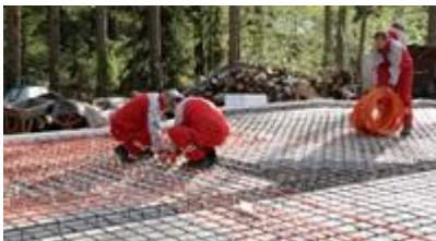
Монтаж трубы теплых полов и коммуникации
