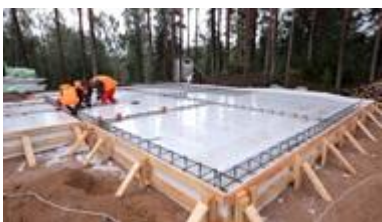
Следует учитывать, что под ребра плиты также следует сделать уширение, в которое будет уложен арматурный каркас
