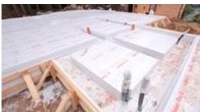
Укладка первого и второго слоя утеплителя
