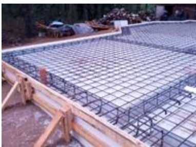
Укладка арматурного каркаса для всей ж/б плиты
