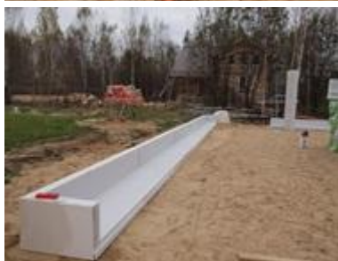
Укладка бортовых элементов
